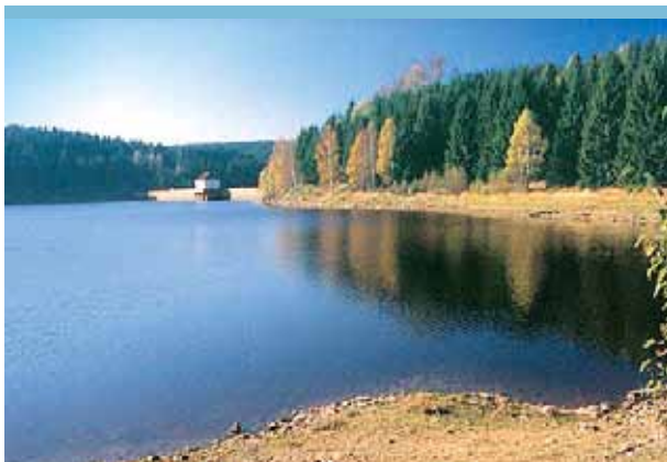
• Die Eckertalsperre im Harz dient als Trinkwasser-Reservoir.
